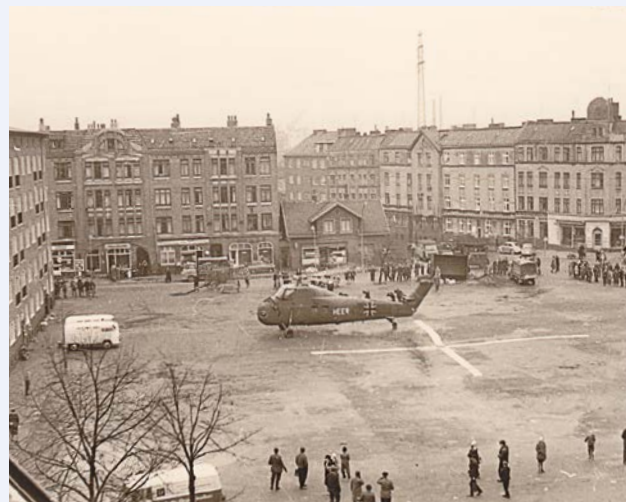
Die Veringstraße in Wilhelmsburg in den Tagen nach der Flut
